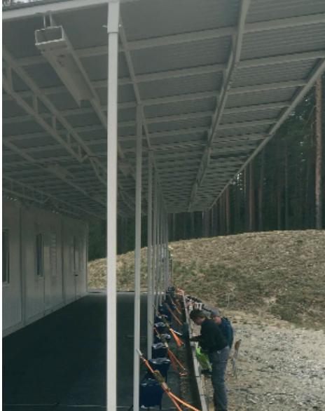
Takkonstruksjonen og containerne opp over alle 16 standplassene. Mangler kun endeveggene.
