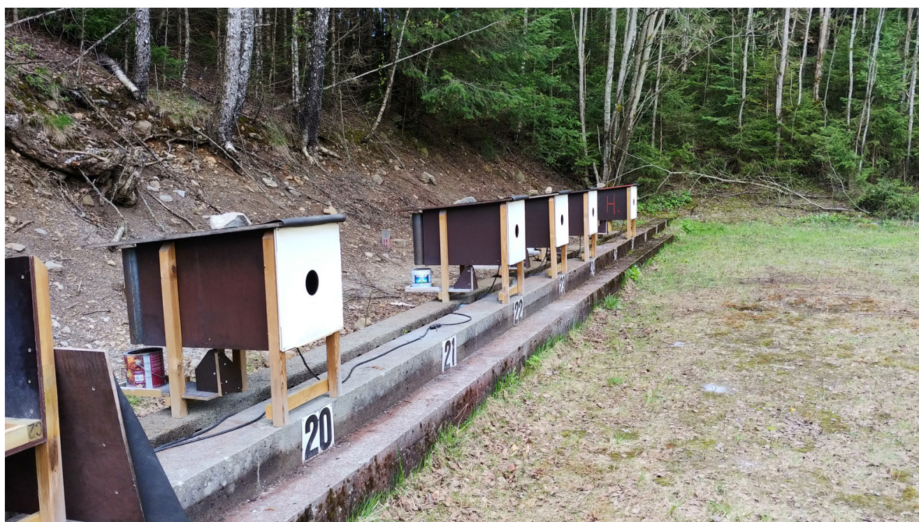
Slik er skivene med kulefangere og blyoppsamling montert nå. De nye husene bygger inn skivene parvis, slik at de er godt beskyttet også mot vær og vind.
