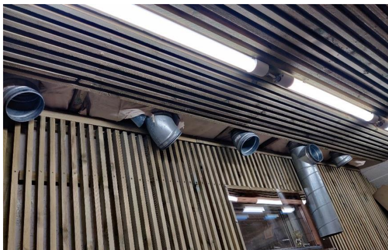
Figur 15: Bilde av plassering av tilluft Horten skytebanehall
