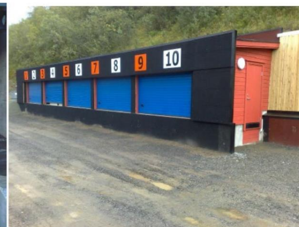
Figur 20 Lamellkulefang Trondenes leir, med en transportskrue i bunnen for utmating av kulerester. (Forsvarsbygg, Håndbok for skyte- og øvingsfelt 2020 - 2022, 2020)
