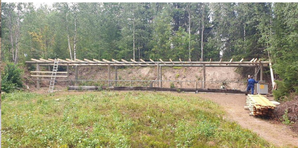
Figur 20 Lamellkulefang Trondenes leir, med en transportskrue i bunnen for utmating av kulerester. (Forsvarsbygg, Håndbok for skyte- og øvingsfelt 2020 - 2022, 2020)
