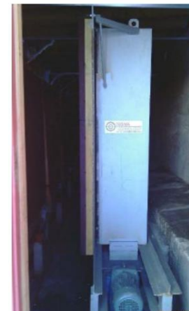
Figur 20 Lamellkulefang Trondenes leir, med en transportskrue i bunnen for utmating av kulerester. (Forsvarsbygg, Håndbok for skyte- og øvingsfelt 2020 - 2022, 2020)
